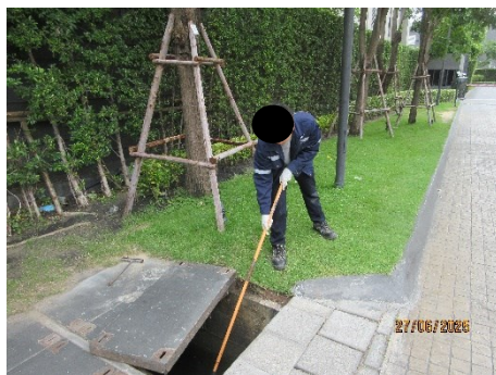
บ่อกักน้ำสุดท้ายของระบบระบายน้ำของโครงการก่อนระบายลงสู่ระบบระบายน้ำ
